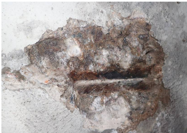
Detail po odstranění povrchových vrstev
