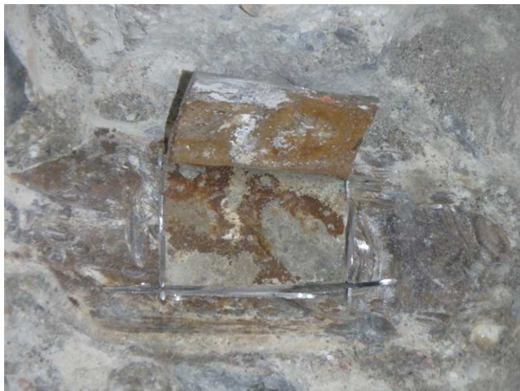
Sonda PV 4 – otevření chráničky – kanálek je plně zainjektovaný – na injektáži je patrná koroze z vnitřního líce chráničky
