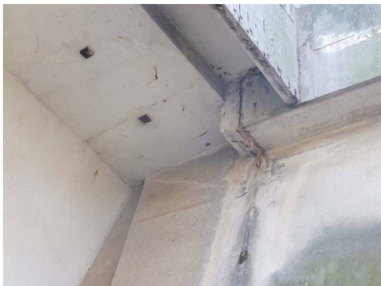
Průsaky s inkrustací a výluhy na líci opěry O6.
