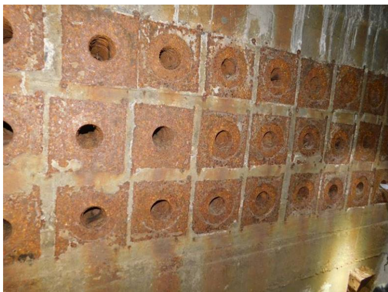
Silná koroze montážních kotev
