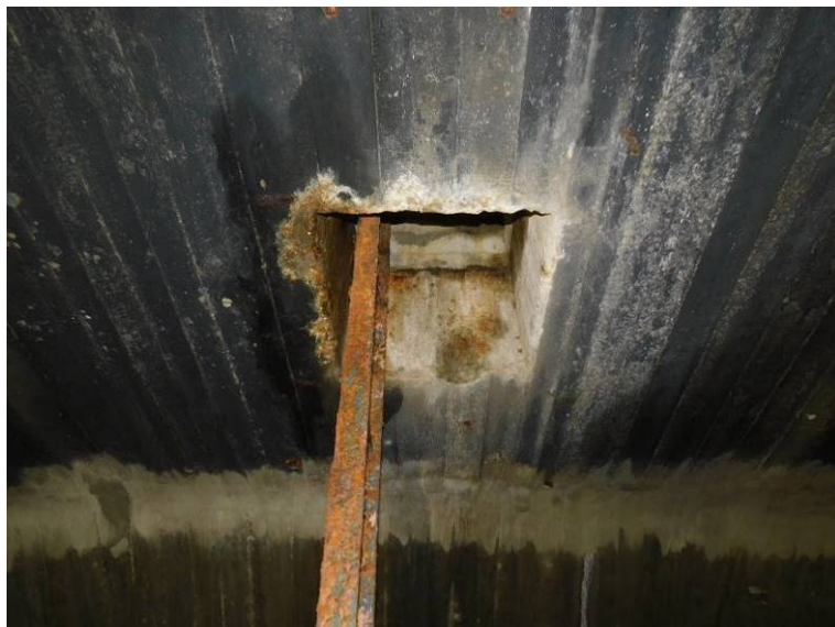
Silná koroze vstupního žebříku
