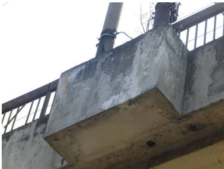
Zatékání s výluhy na bok římsy u stožáru trakčního vedení.
