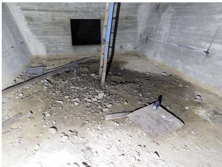
Spadaný štěrk z kolejového lože, zatékání do komory vstupním otvorem v poli 5
