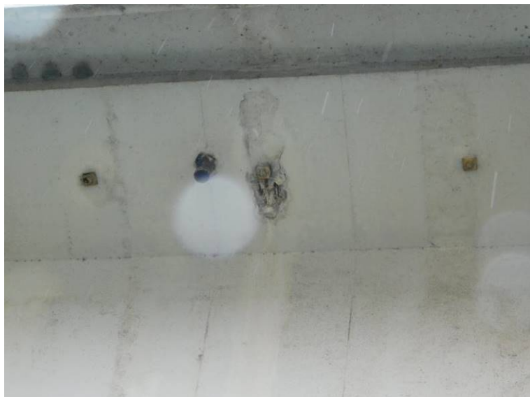
Odpadá krycí vrstva betonu na konzole v místě kotevního šroubu římsy v poli 2
