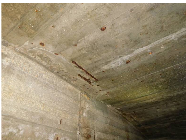
Lokální separace krycí vrstvy, koroze odhalené výztuže v poli 5
