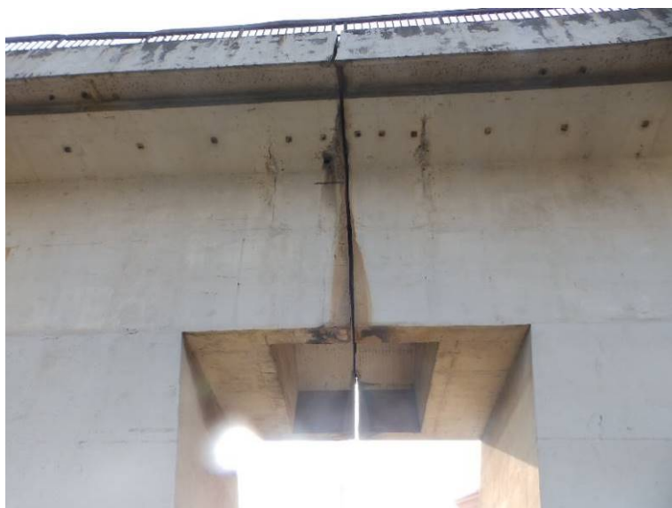
Svislé trhliny procházející do konzoly nad pilířem P 05 na pravé straně
