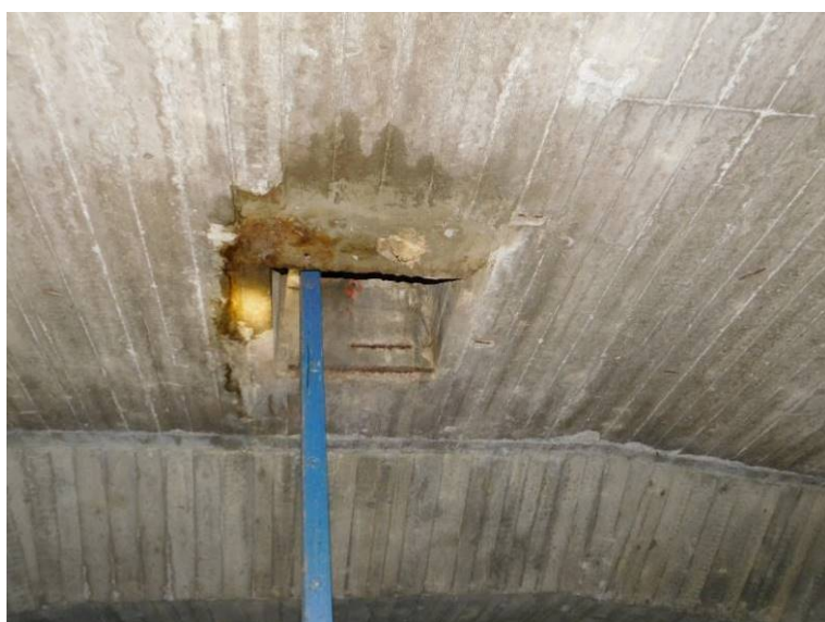
Mokrý beton v místě vstupního otvoru, separace krycí vrstvy, odhalená výztuž koroduje
