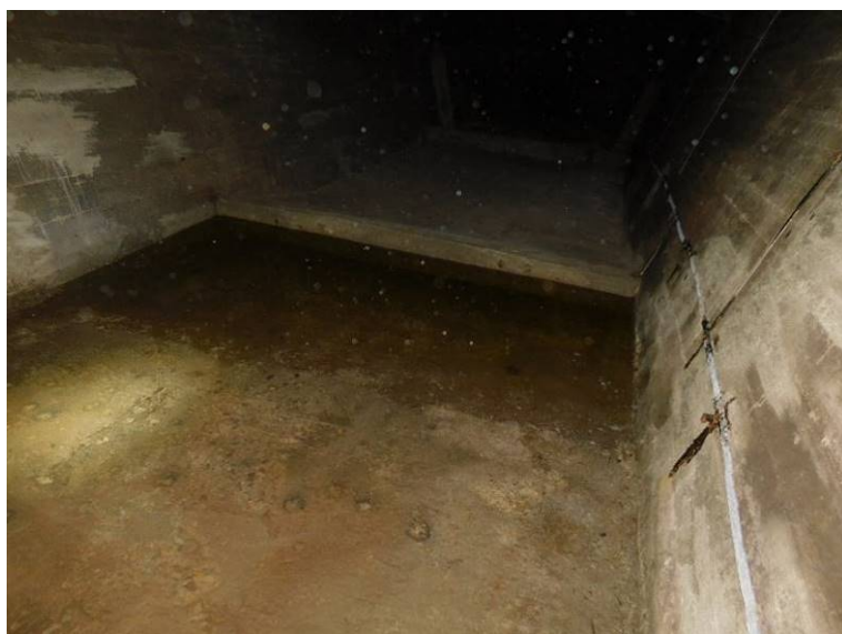
V jedné části komory je stále voda o hloubce až 15 cm.
