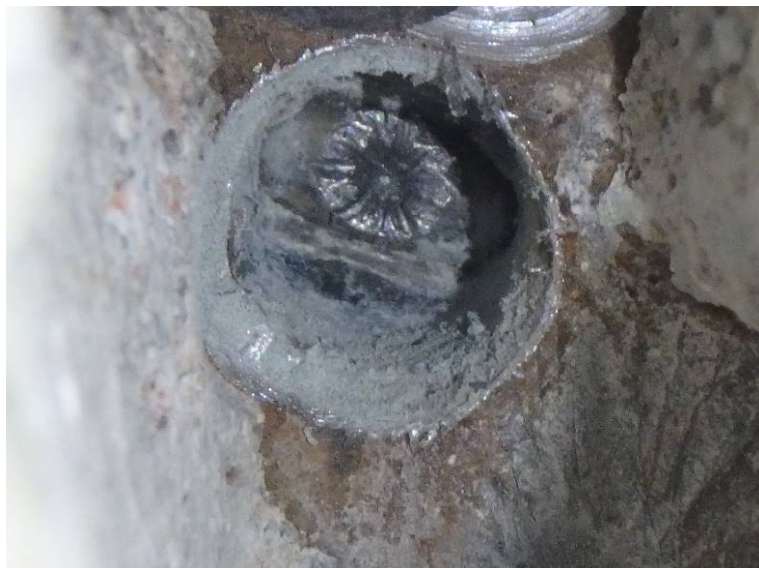
Sonda PV 10 – předpínací dráty bez koroze
