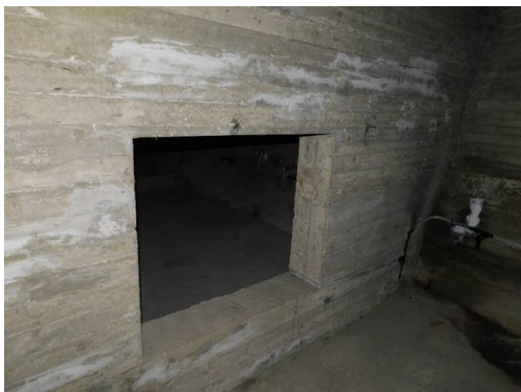
Pohled na příčnou stěnu s průlezným otvorem rozdělující hlavní komoru na 4 menší komory
