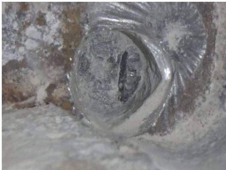
Sonda PV 13 – předpínací dráty bez koroze
