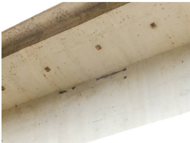
Separace krycí vrstvy nad korodující výztuží na levém boku nosné konstrukce v poli 5
