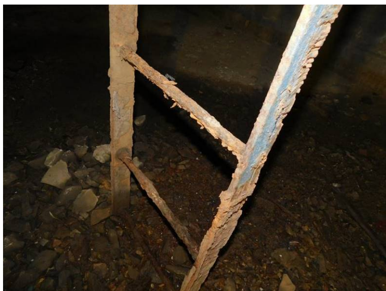
Silná koroze přístupového žebříku v poli 5
