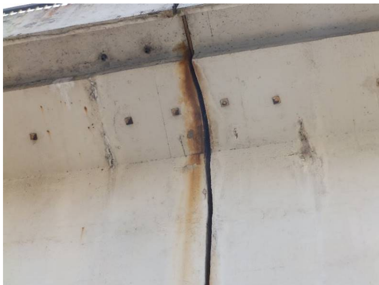
Svislé trhliny na nosné konstrukci zasahující do konzoly nad pilířem P2
