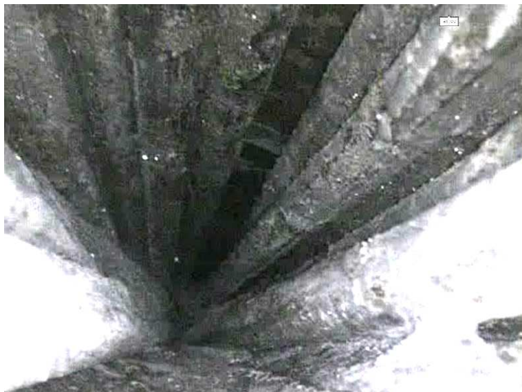
Sonda PVK 9 – pohled endoskopem pod kotvu – na snímku je patrná sedlá hladina injektážní malty a volné dráty nad touto hladinou
