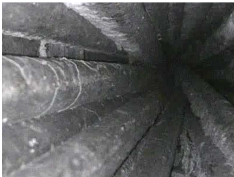
Sonda PVK 3 – pohled endoskopem pod kotvu – detail drátů
