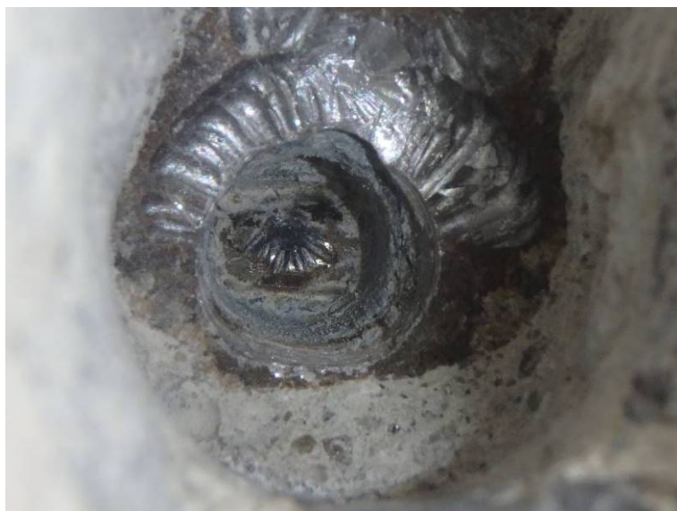
Sonda PV 7 – předpínací dráty bez koroze
