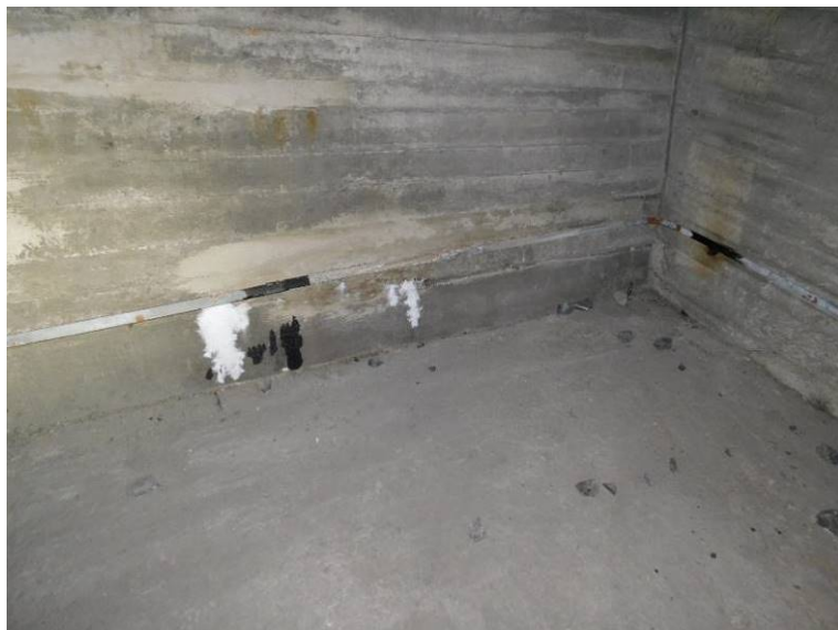
Lokální suchý průsak s výluhy na stěně v poli 2
