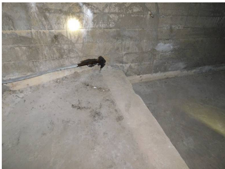
Šikmá trhlina s výluhy na spodní desce v poli 1
