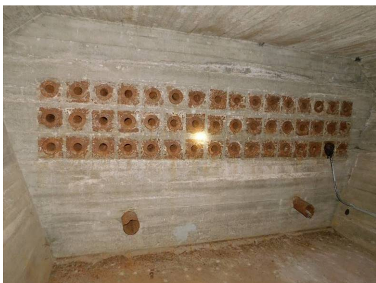
Pohled na silně korodující montážní kotvy v poli 1 nad pilířem P2
