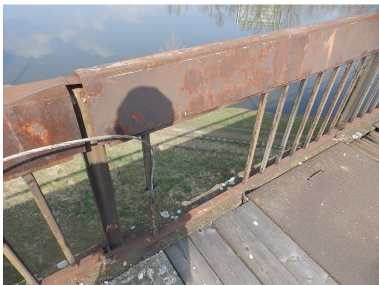
Silná koroze zábradlí, chybějící svislá výplň.
