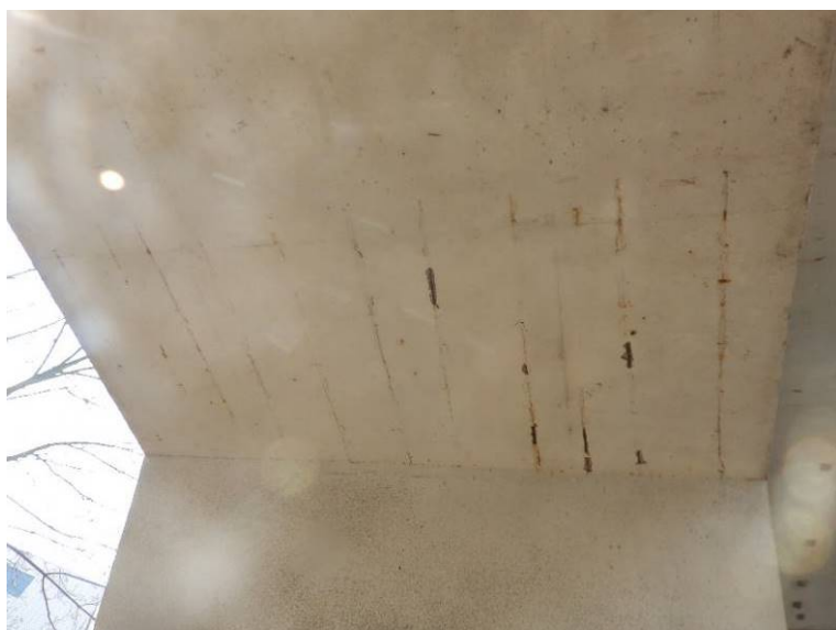
Prokreslená korodující výztuž na spodním líci nosné konstrukce v poli 5
