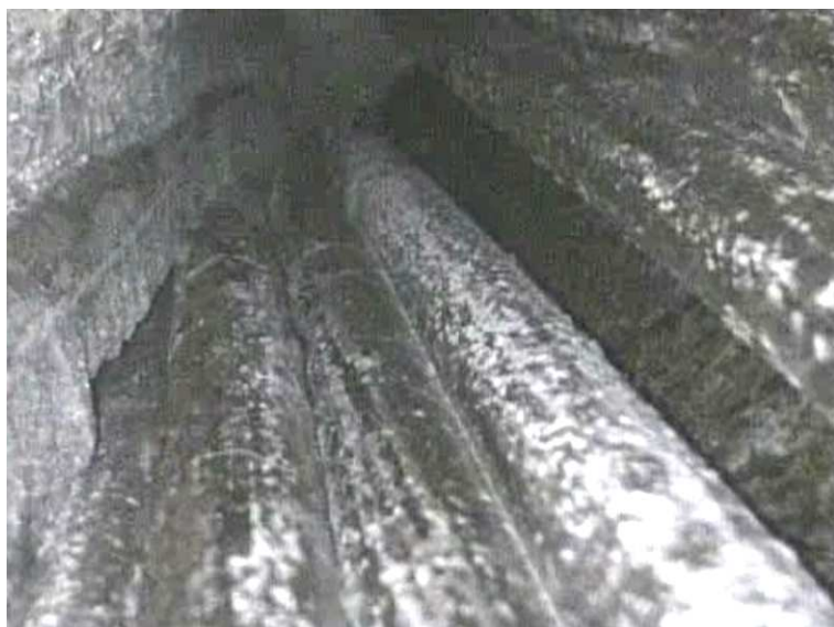
Sonda PVK 8 – pohled endoskopem pod kotvu – detail drátů
