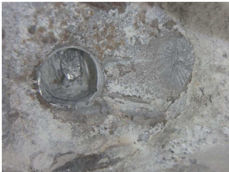
Sonda PV 21 – odvrtání chráničky – kanálek je zainjektovaný, předpínací dráty bez koroze
