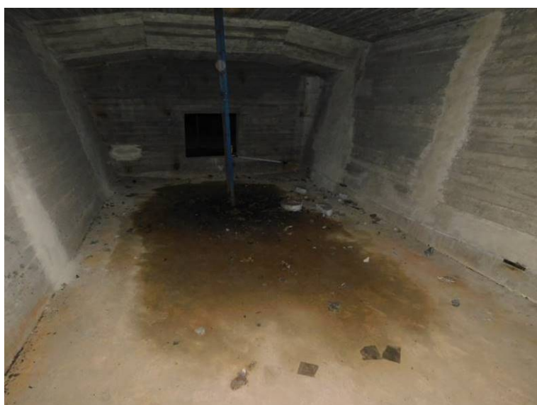
Zatékání vstupním otvorem do komory v poli 3
