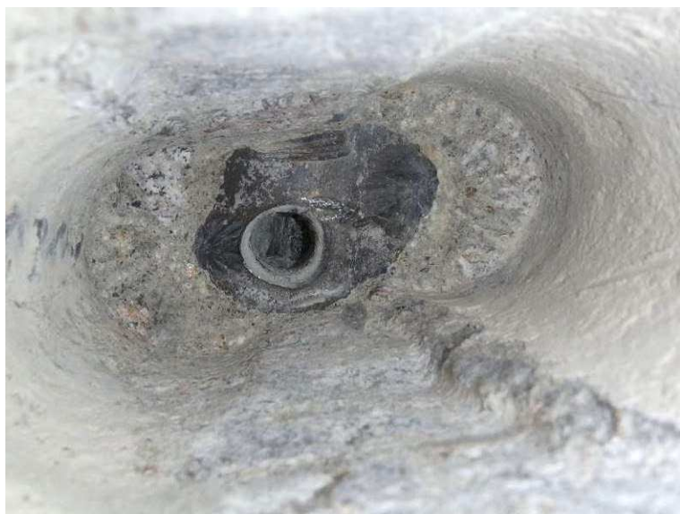
Sonda PV 22 – předpínací dráty bez koroze
