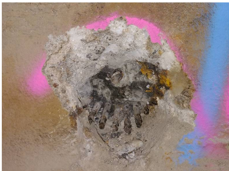
Sonda PVK 2 – po odstranění dobetonávky, drobná koroze v krajní části kotvy
