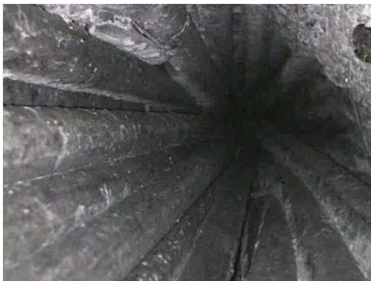
Sonda PVK 3 – pohled endoskopem pod kotvu – na snímku je patrná dutina pod kotvou a předpínací dráty
