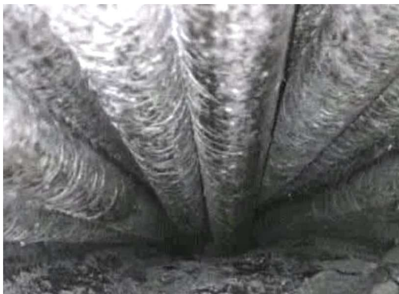
Sonda PVK 7 – pohled endoskopem pod kotvu – detail drátů
