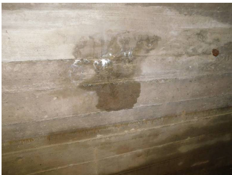
Průsaky s výluhy na stěně
