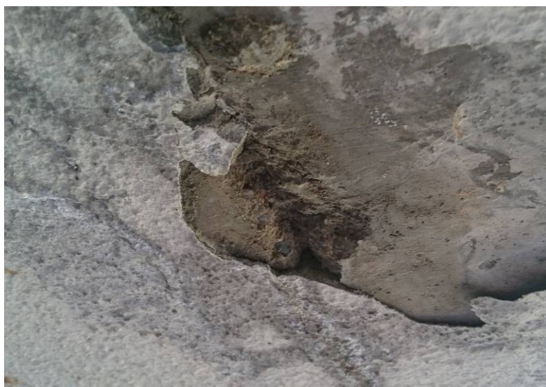
Detail poruchy – šíře trhliny je na povrchu až cca 3 mm. Směrem do hloubky se porucha zavírá, struktura betonu je mokrá a narušená. Ve hloubce 10-20 mm je již jen vlasová trhlina. Na snímku je patrná původní omítka zasahující do trhliny
