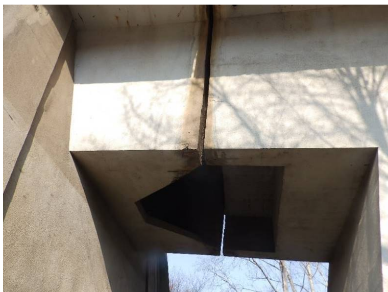
Zatékání dilatační spárou u opěry O6
