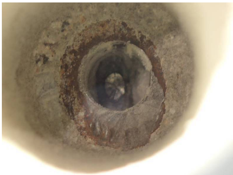
Sonda PV 31 – kanálek je zainjektovaný, předpínací dráty bez koroze
