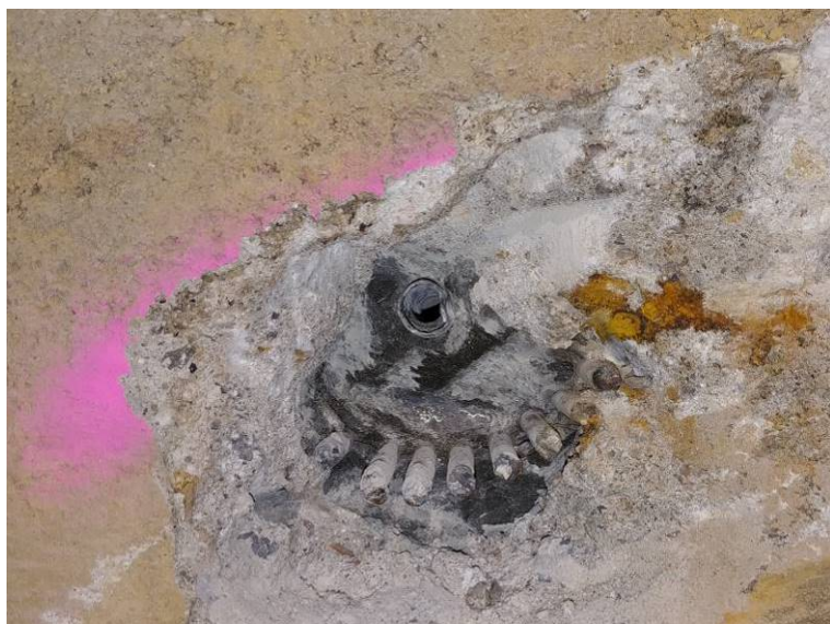
Sonda PVK 4 – po odstranění dobetonávky, drobná koroze v krajní části kotvy
