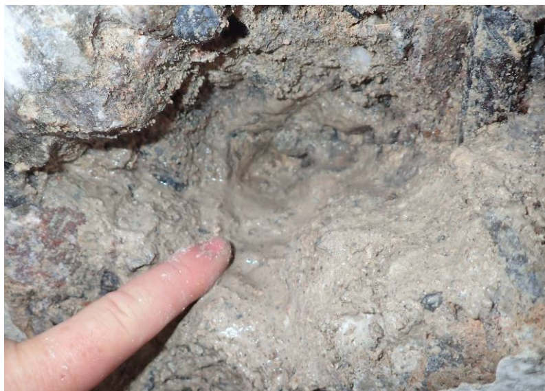
Detail po odstranění povrchových vrstev, nalezena svislá výztuž a oblast nedostatečně zhutněného betonu
