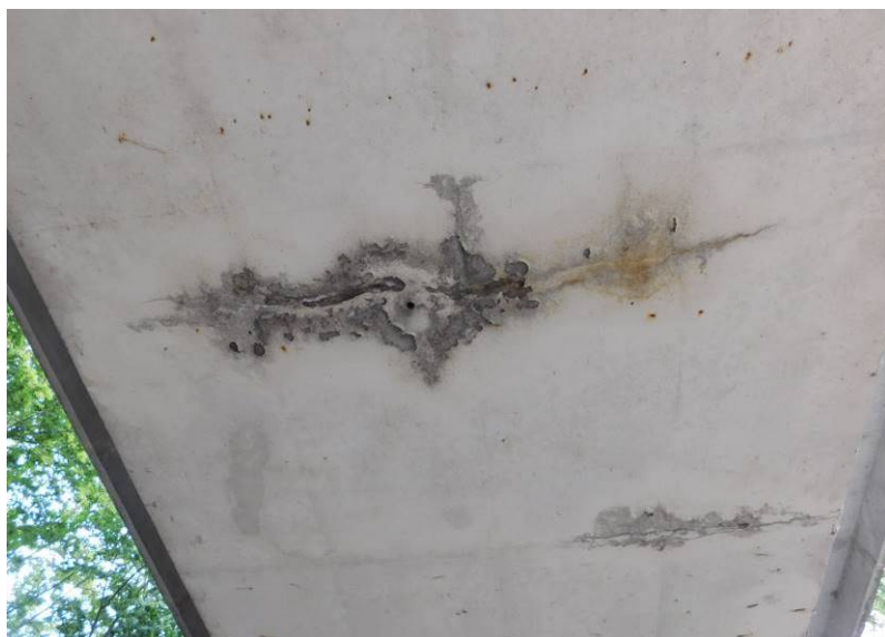
Pohled na příčnou trhlinu na spodním líci s průsaky
