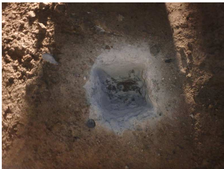
Sonda PV 4 – pohled na nalezenou tlustostěnnou chráničku
