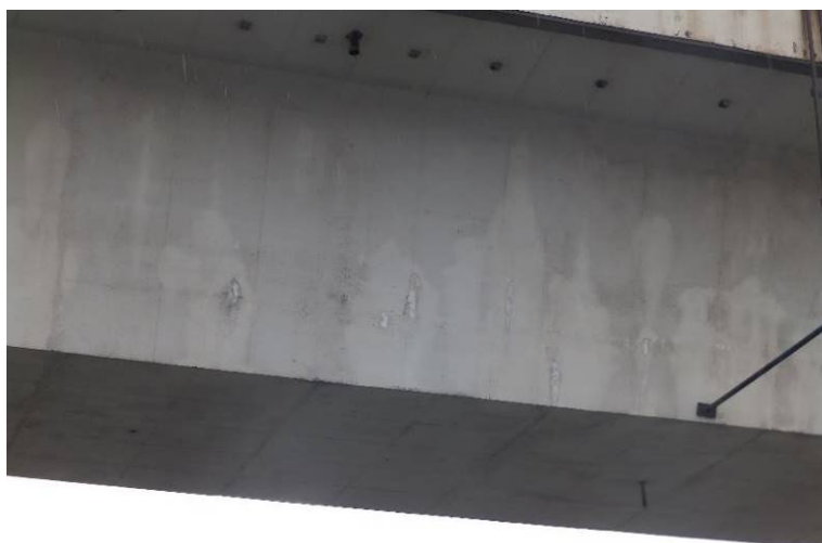
Průsaky na levém boku nosné konstrukce v poli 2
