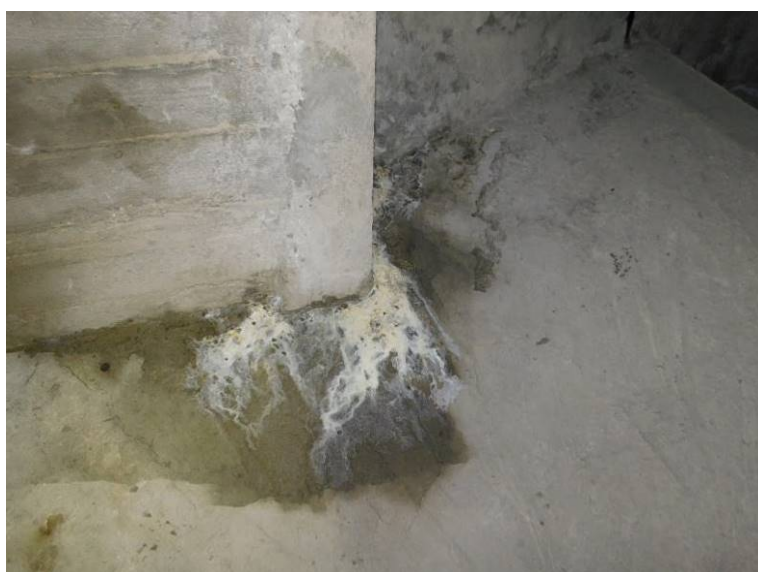
Lokální průsak s výluhy v poli 1
