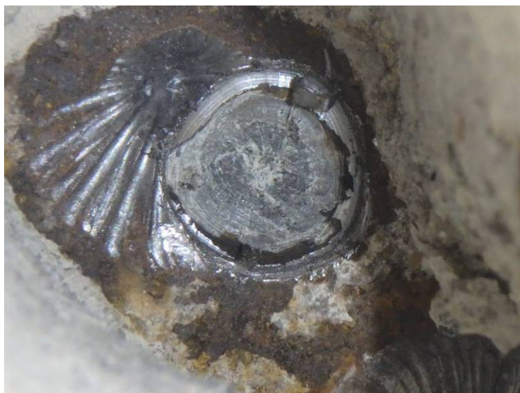
Sonda PV 6 – odvrtání chráničky – kanálek je zainjektovaný
