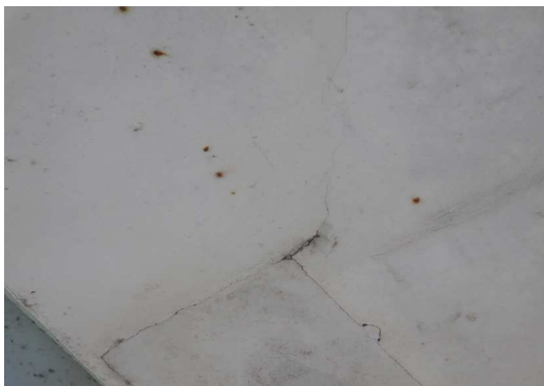
Pohled na dobetonávku s typickou šikmou trhlinou na spodním líci konstrukce
