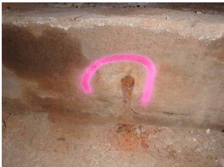
Sonda PVK 3 – pohled na kotvu se stopami koroze na povrchu dobetonávky – před zahájením prací
