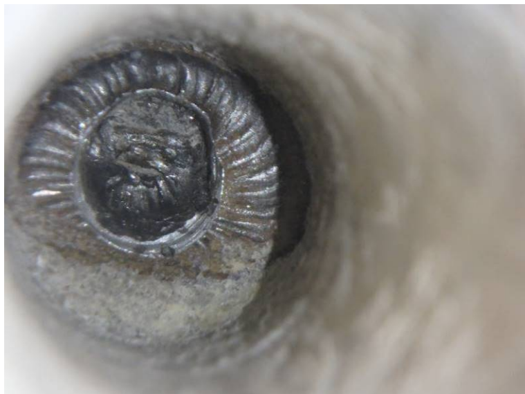
Sonda PV 28 - předpínací dráty bez koroze, kanálek zainjektovaný
