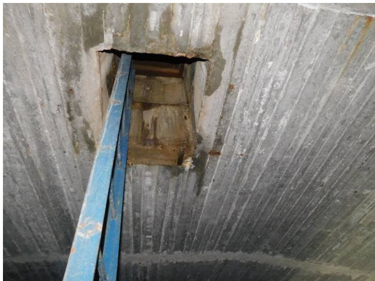
Beton okolo vstupního otvoru je nasycený vodou
