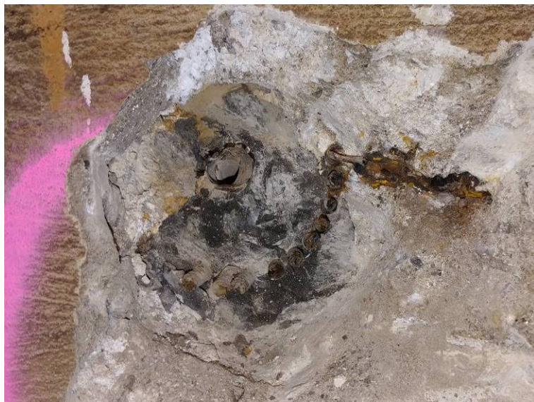
Sonda PVK 8 – po odstranění dobetonávky, koroze drátů ve spodní části
