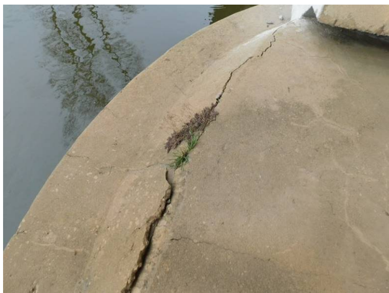
Trhliny na horním líci dříku pilíře P4
