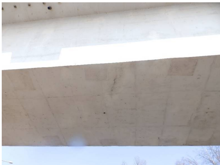
Příčná trhlina na spodním líci pole 1
