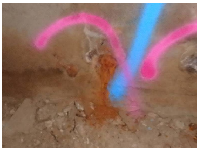
Sonda PVK 2 – pohled na kotvu se stopami koroze na povrchu dobetonávky – před zahájením prací
