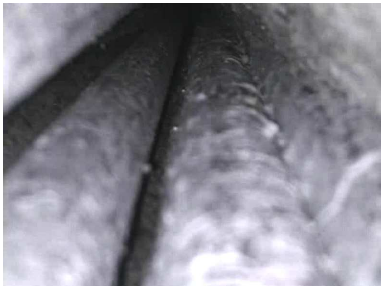
Sonda PVK 6 – pohled endoskopem pod kotvu – detail drátů
