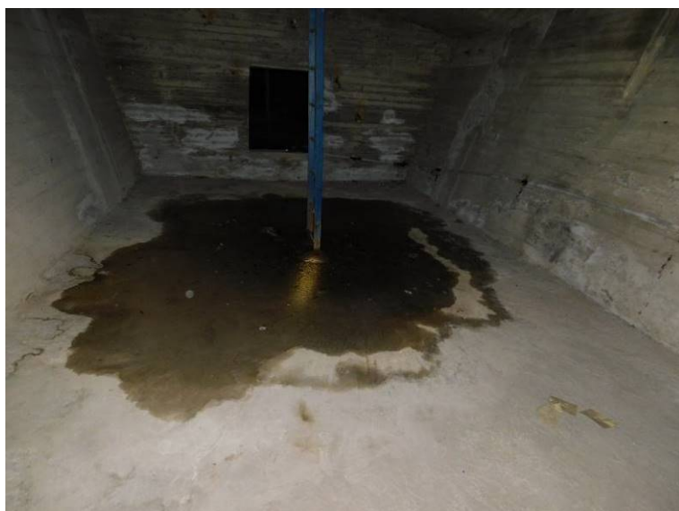
Zatékání do komory vstupním otvorem z kolejiště v poli 1
