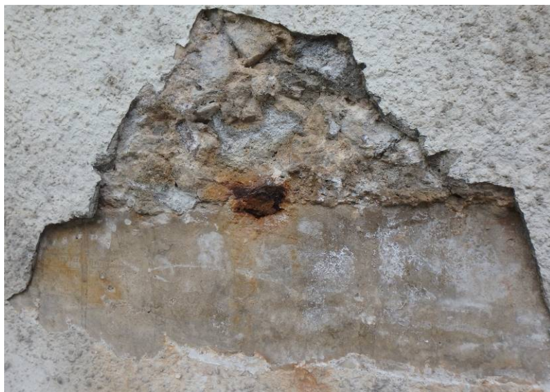
Detail po odstranění separované omítky
