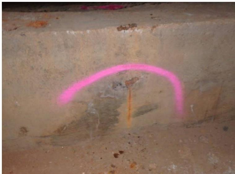
Sonda PVK 4 – pohled na kotvu se stopami koroze na povrchu dobetonávky – před zahájením prací
