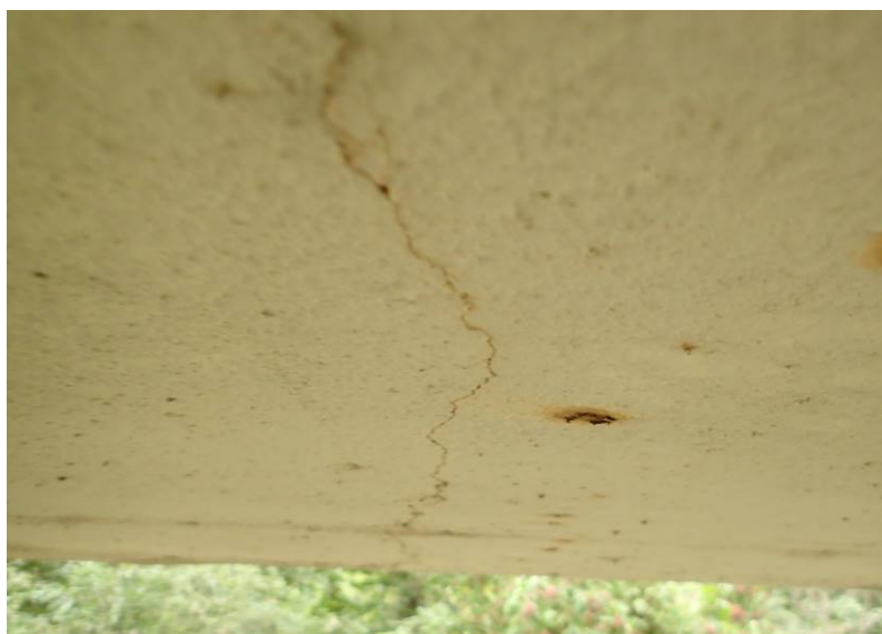
Detail trhliny na spodním líci
