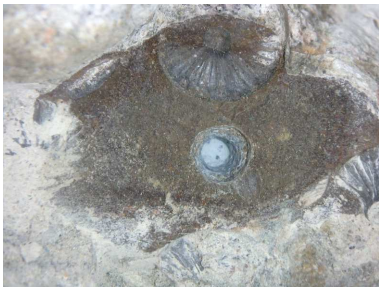
Sonda PV 3 – odvrtání chráničky – kanálek je plně zainjektovaný
