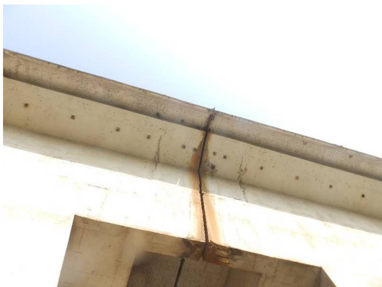
Zatékání na nosnou konstrukci z dilatační spáry nad pilířem P5
