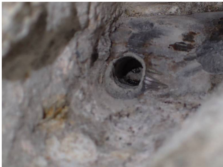
Sonda PV 30 – předpínací dráty bez koroze
