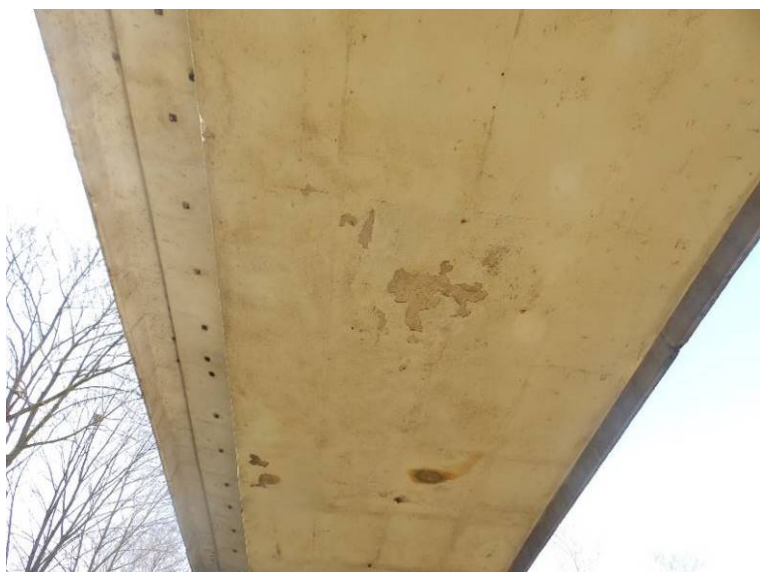
Odlupování povrchové úpravy nosné konstrukce na spodním líci v poli 5
