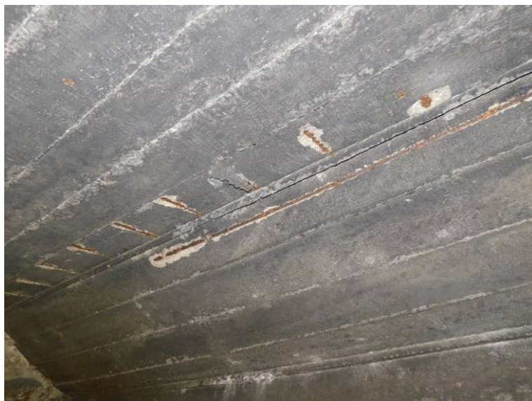
Lokální separace krycí vrstvy betonu, odhalená výztuž koroduje
