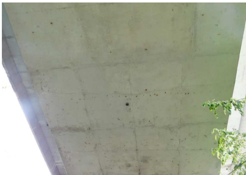
Pohled na příčnou trhlinu na spodním líci (u odvodňovacího otvoru)
