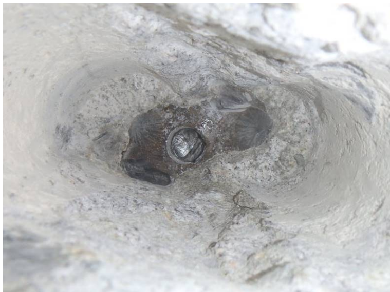
Sonda PV 23 – předpínací dráty bez koroze
