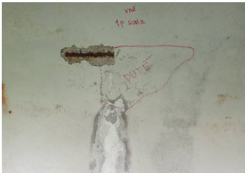
Dutě znějící plocha nad výluhem
