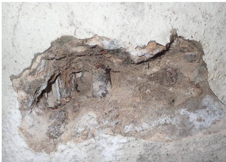
Detail po odstranění povrchových vrstev, nalezen svislý předepjatý třmínek a svislá betonářská výztuž.
