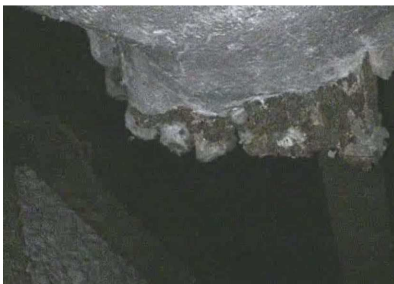
Průzkum dutiny endoskopem – pohled na kotvu – jsou viditelné dráty vyčnívající přes kuželík a injektážní trubička. Pod dobetonávkou (na snímku dole vlevo) je patrná „kamufलाžní“ deska s betonářskou výztuží
