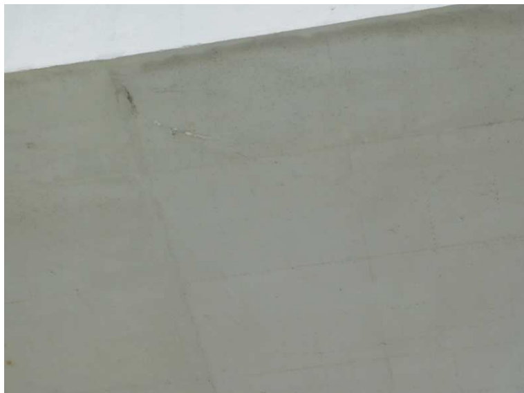
Šikmá trhлина s výluhy na spodním líci nosné konstrukce v poli 3
