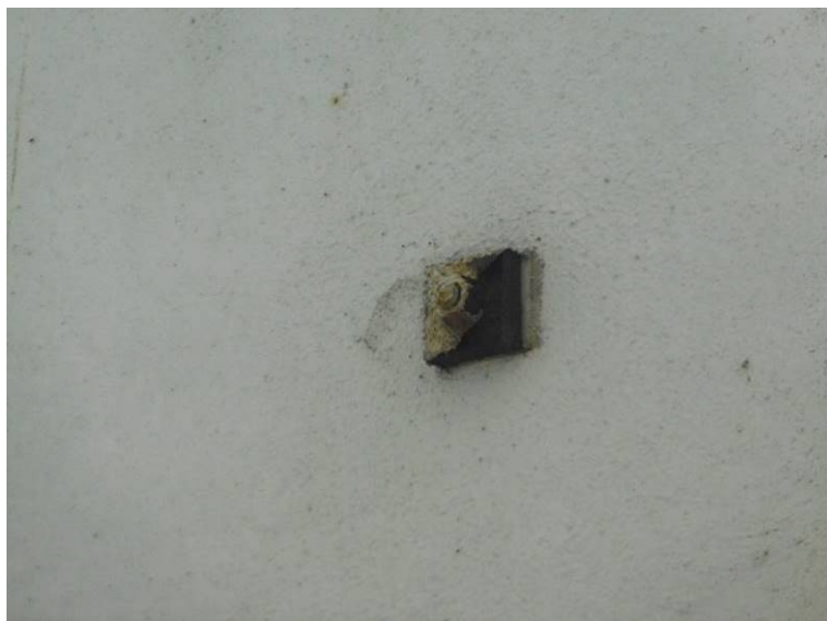
Silná koroze kotevních šroubů římsy
