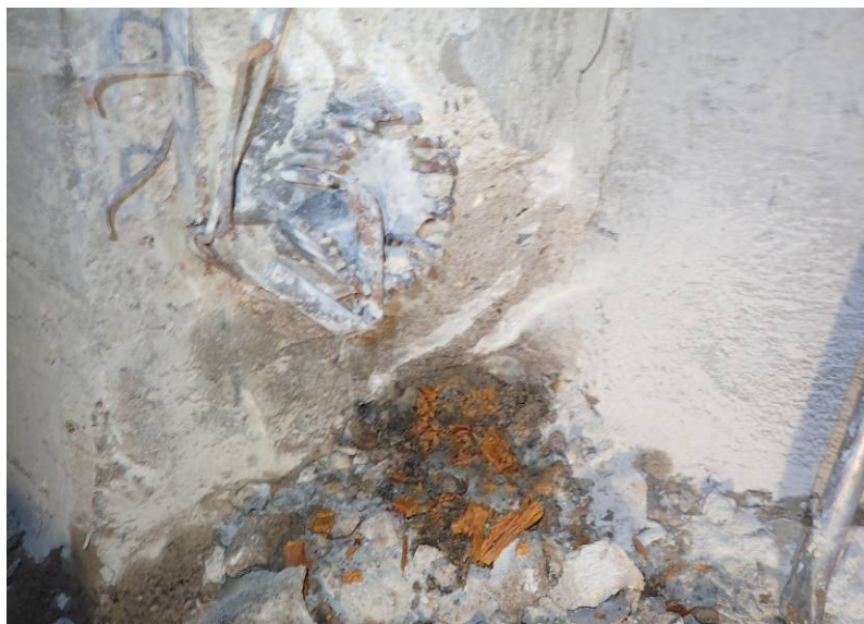
Po odbourání byla zjištěna zabetonovaná zetlelá dřevěná rozpěrka, kterou se realizoval průsak.
