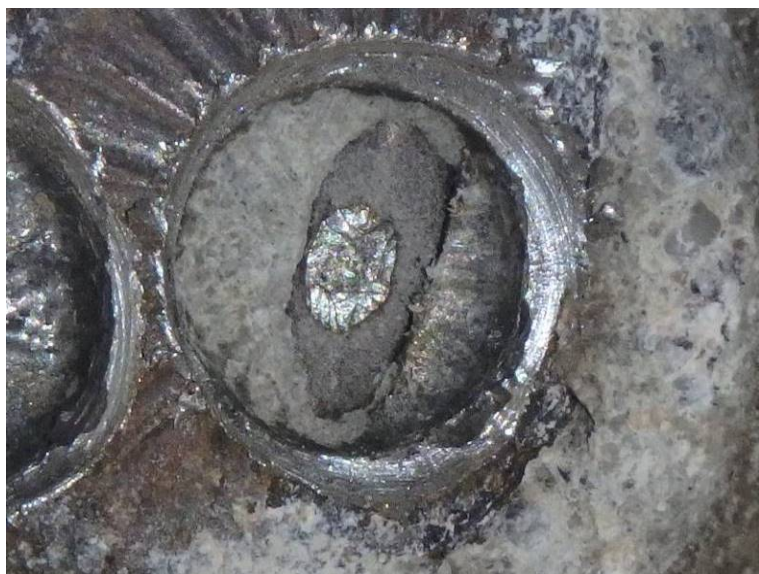
Sonda PV 17 – předpínací dráty bez koroze
