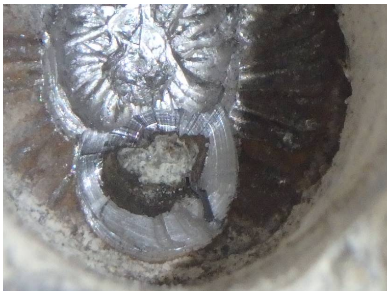
Sonda PV 16 – odvrtání chráničky – kanálek je zainjektovaný
