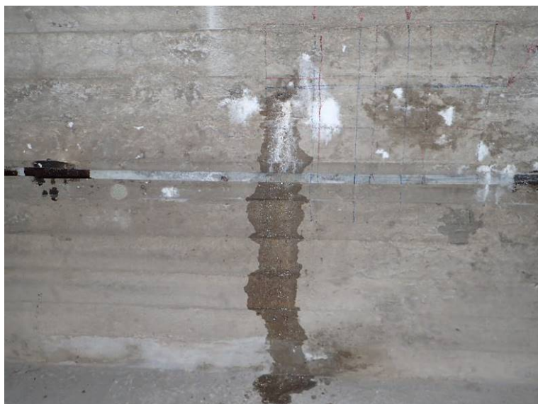
Sonda PV 19 – v místě vody vytékající ze stěny
