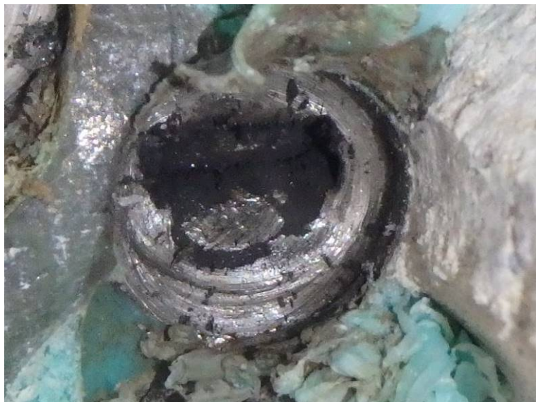
Sonda PV 18 – kanálek je nedostatečně zainjektovaný, dráty mají na sobě černý povlak
