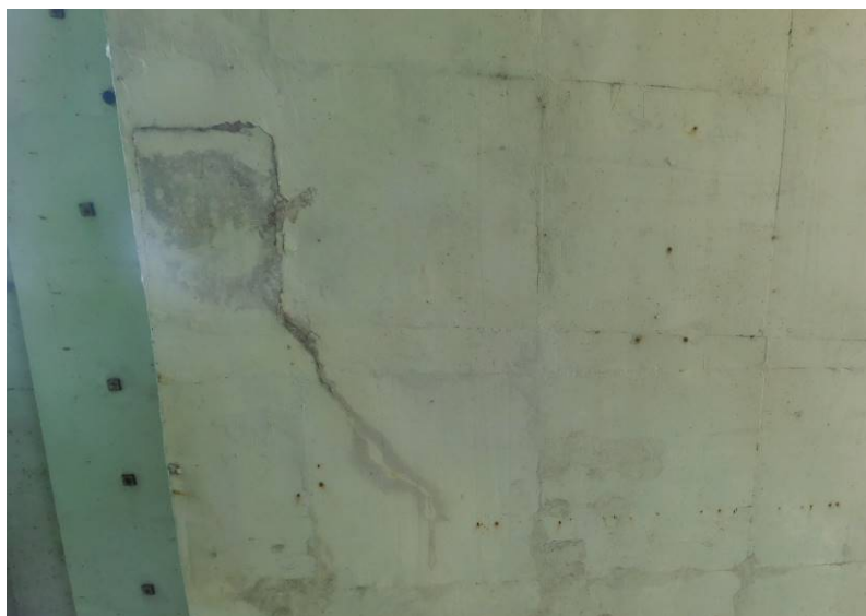
Pohled na dobetonávku v poli 1 s průsaky a typickou šikmou trhlinou na spodním líci
