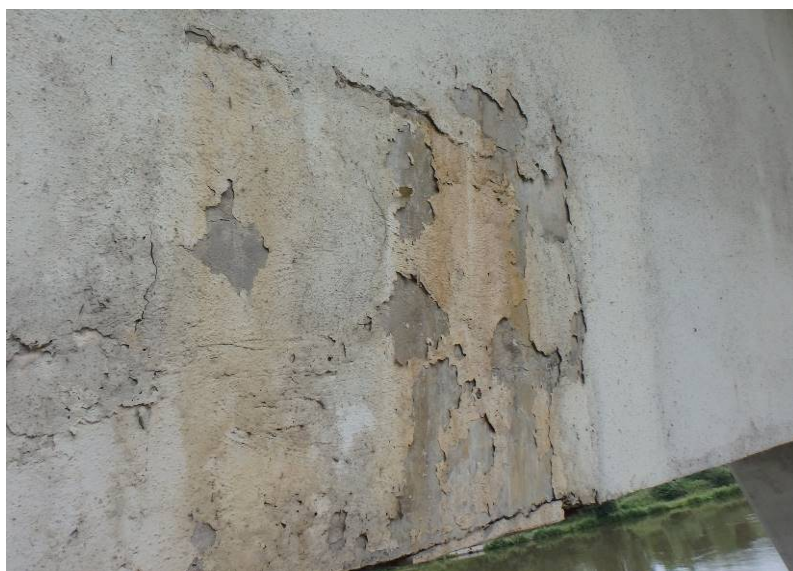
Detail dobetonávky
