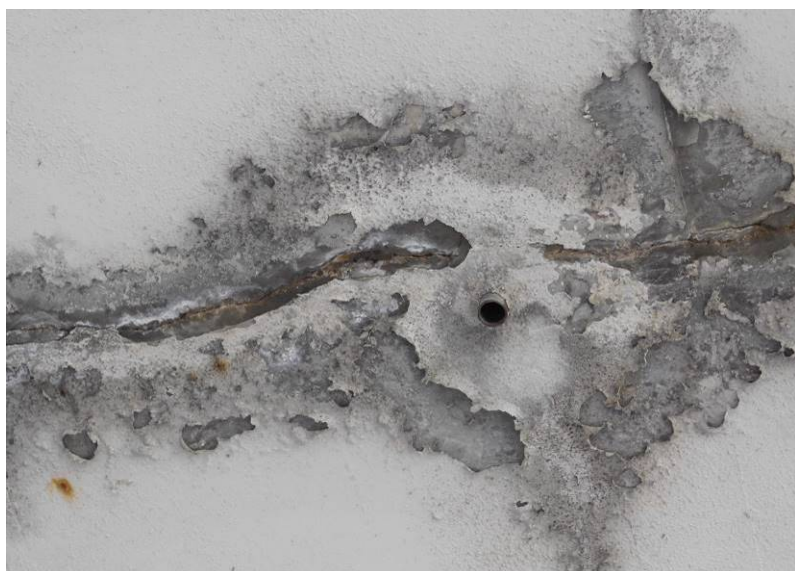
Detail poruchy, v těsné blízkosti trhliny je odvodňovací trubička
