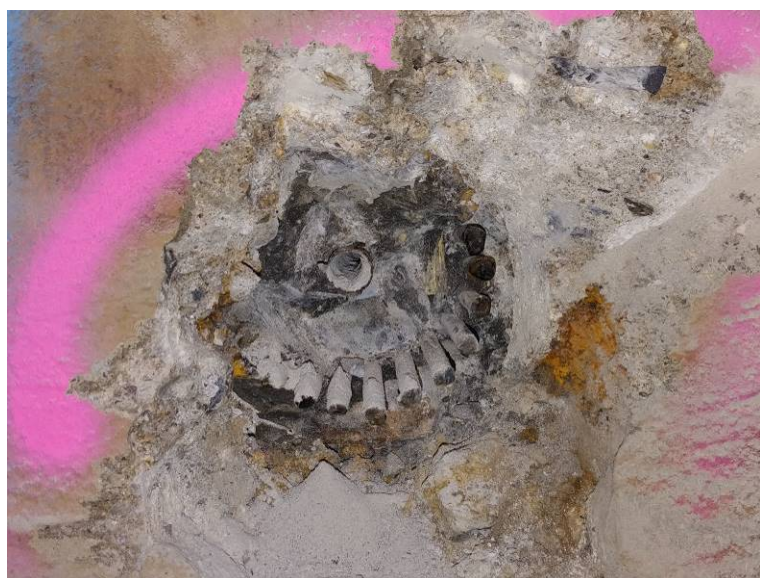
Sonda PVK 1 – po odstranění dobetonávky
