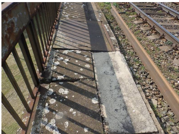
Uvolněný ocelový poklop.
