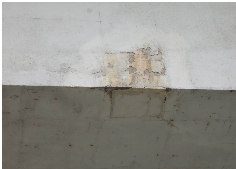
Pohled na dobetonávku v poli 4 s průsaky a typickou šikmou trhlinou na spodním líci
