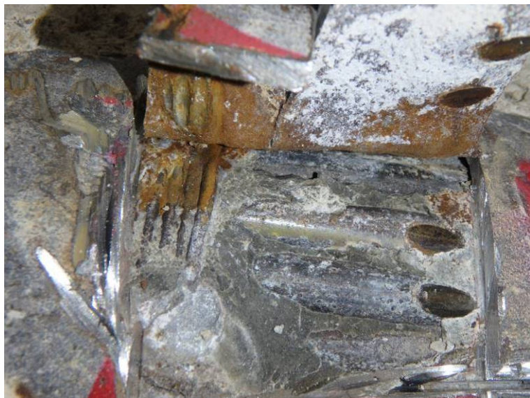
Sonda PV 1 – detail předpínacích drátů
