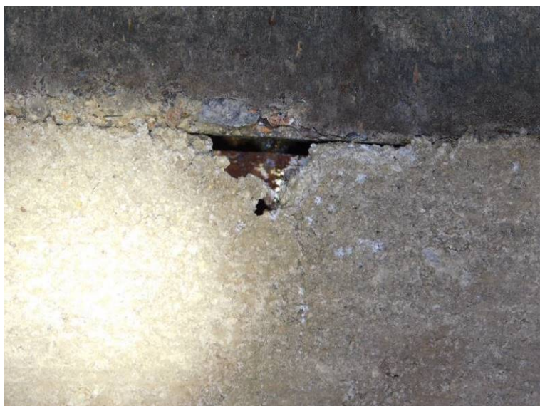
Nedostatečně probetonovaná dobetonávka předpínacích kotev v poli 5
