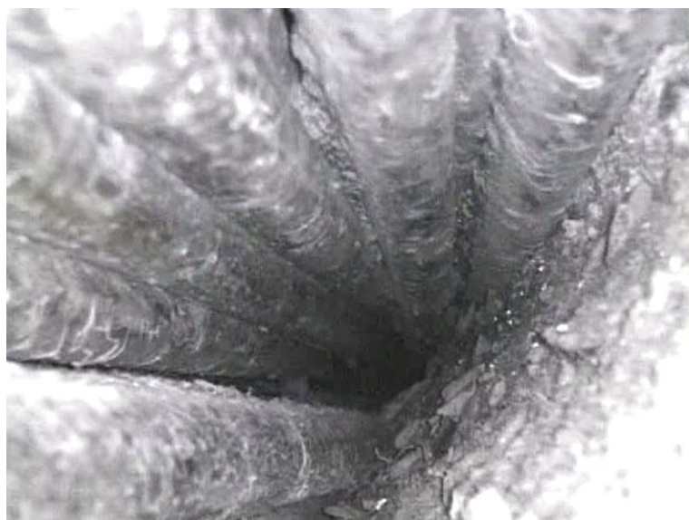
Sonda PVK 1 – pohled endoskopem pod kotvu – na snímku je patrná sedlá hladina injektážní malty a volné dráty nad touto hladinou
