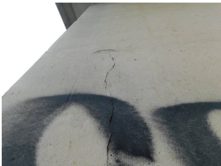
Svislá trhlina na vnitřní stěně stojky do pole 3
