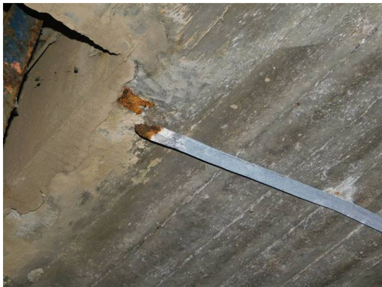
Překorodovaný uzemňovací pásek v poli 5
