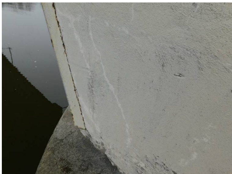
Šikmá vlasová trhlina na stojce do pole 2 na pilíři P3
