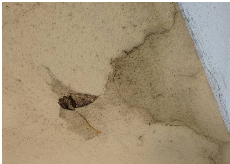
Pohled na poruchu se separací povrchových vrstev
