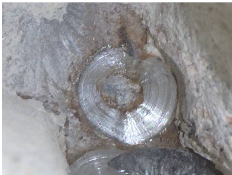
Sonda PV 10 – odvrtání chráničky – kanálek je zainjektovaný
