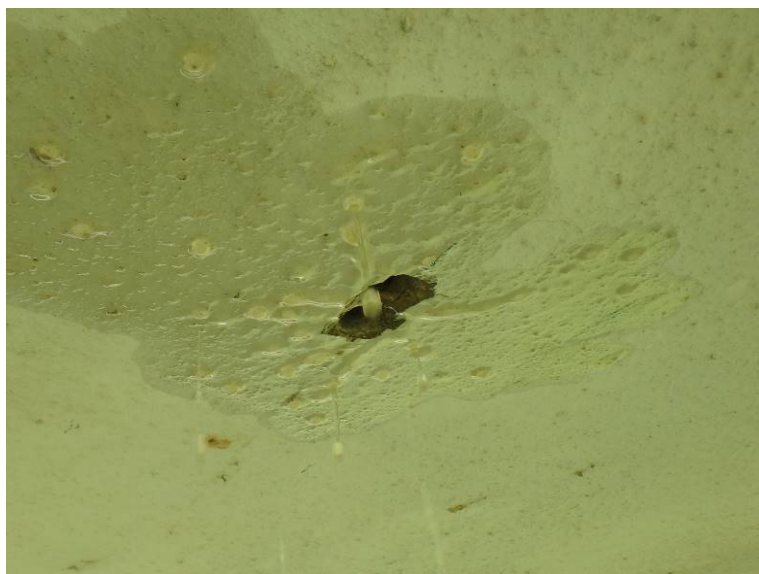
Sonda PV 9 – nalezena prázdná chránička, při odvrtání z ní vytékala delší dobu voda
