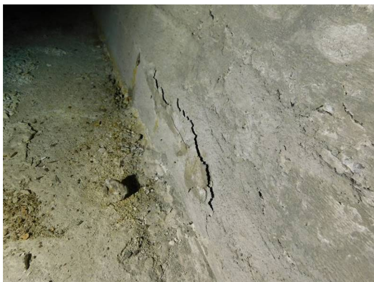
Separace krycí vrstvy v dolní části stěny v poli 5
