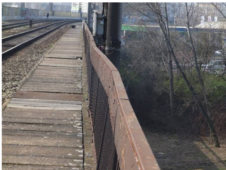
Vyhnuté a deformované zábradlí na pravé straně mostu.
