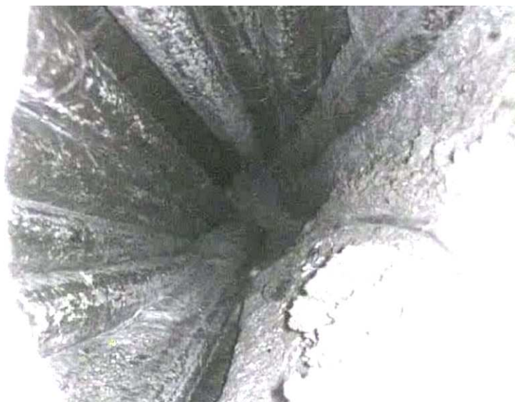
Sonda PVK 8 – pohled endoskopem pod kotvu – na snímku je patrná sedlá hladina injektážní malty a volné dráty nad touto hladinou
