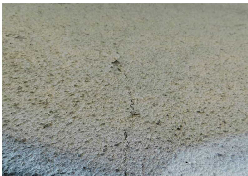
Detail typické vertikální trhliny na jedné z rámových stojek, kde se prokresluje v povrchové úpravě
