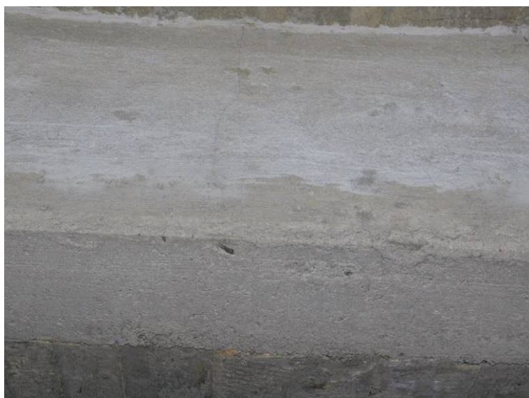
Vlasová trhlina v horní dobetonávce kotev v poli 1
