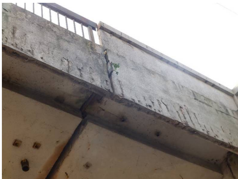
Separace krycí vrstvy na boku římse, odhalená výztuž koroduje.
