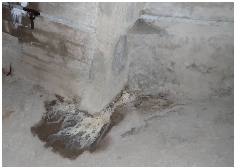
Pohled na průsaky v místě dobetonávky kotev
