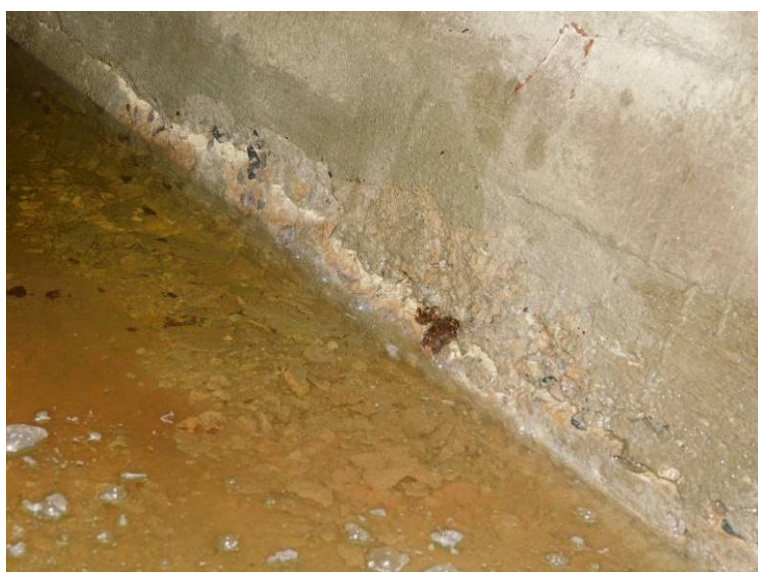
Ve spodní části po obvodu komory, dochází k degradaci betonu a k separaci krycí vrstvy
