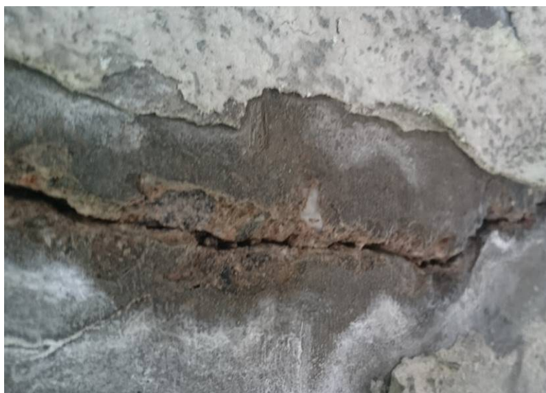
Detail poruchy, šíře trhliny je na povrchu 2-3 mm
