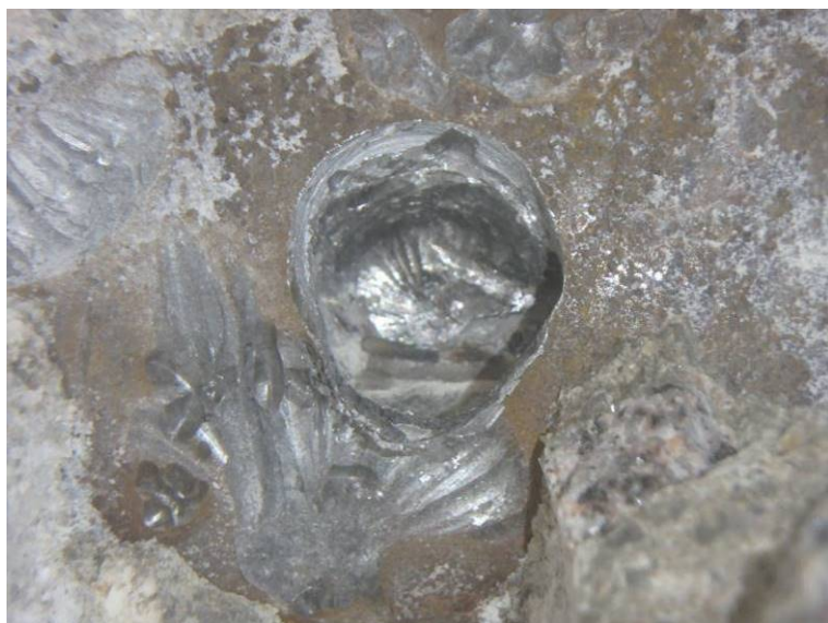
Sonda PV 24 – kanálek je zainjektovaný, předpínací dráty bez koroze
