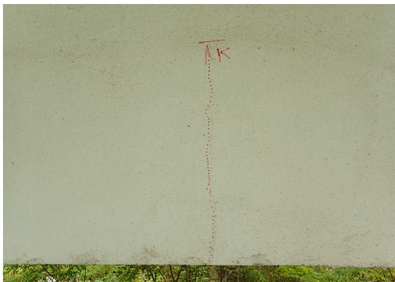
Detail trhliny na pravé boční ploše (trasování trhliny fixem)
