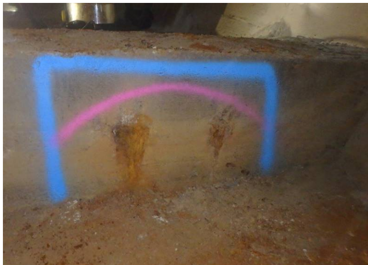
Sonda PVK 6 – pohled na kotvu se stopami koroze na povrchu dobetonávky – před zahájením prací
