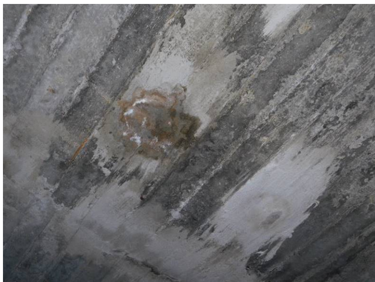
Lokální průsak v místě sanovaných montážních otvorů v horní desce v poli 2
