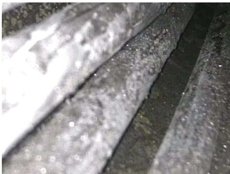
Sonda PVK 9 – pohled endoskopem pod kotvu – detail drátů
