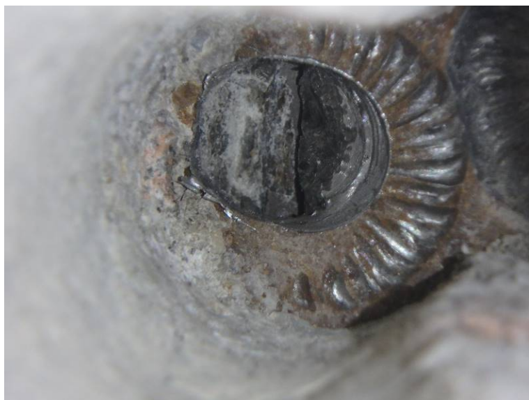
Sonda PV 27 - předpínací dráty bez koroze
