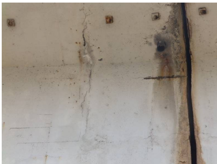
Detail svislé trhliny
