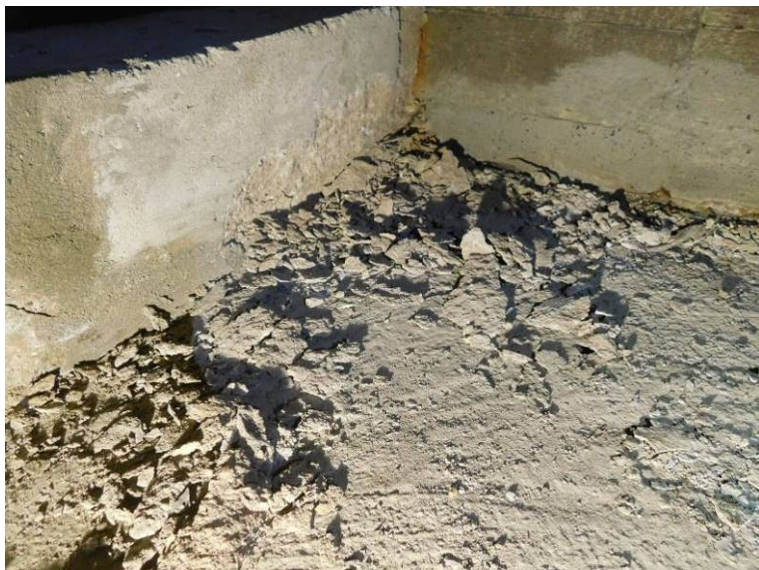
Degradace a nečistoty na betonu ve spodní části
