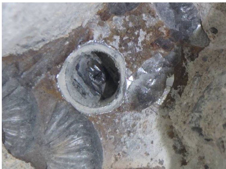
Sonda PV 11 – předpínací dráty bez koroze
