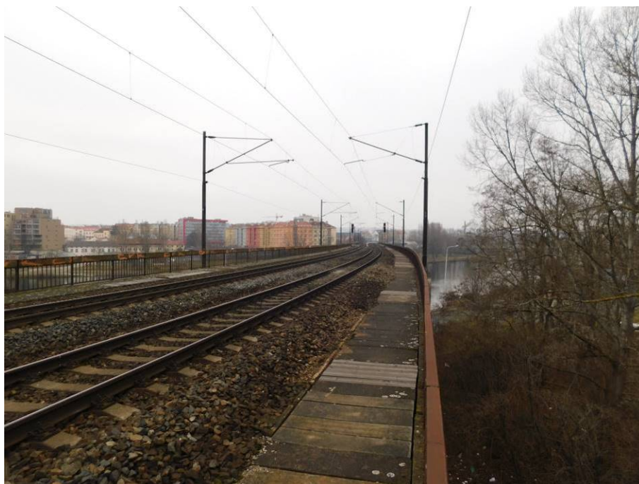
Pohled na uspořádání mostního svršku
