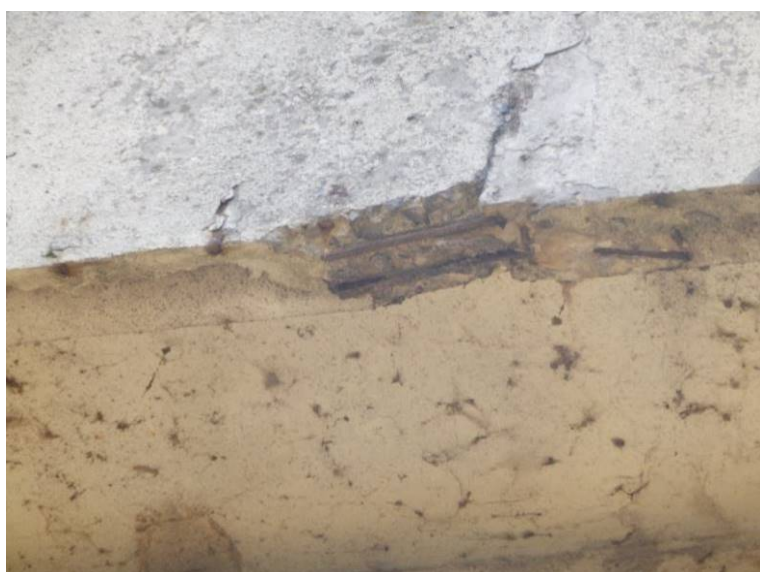
Odpadlá krycí vrstva na římse, koroze výztuže.
