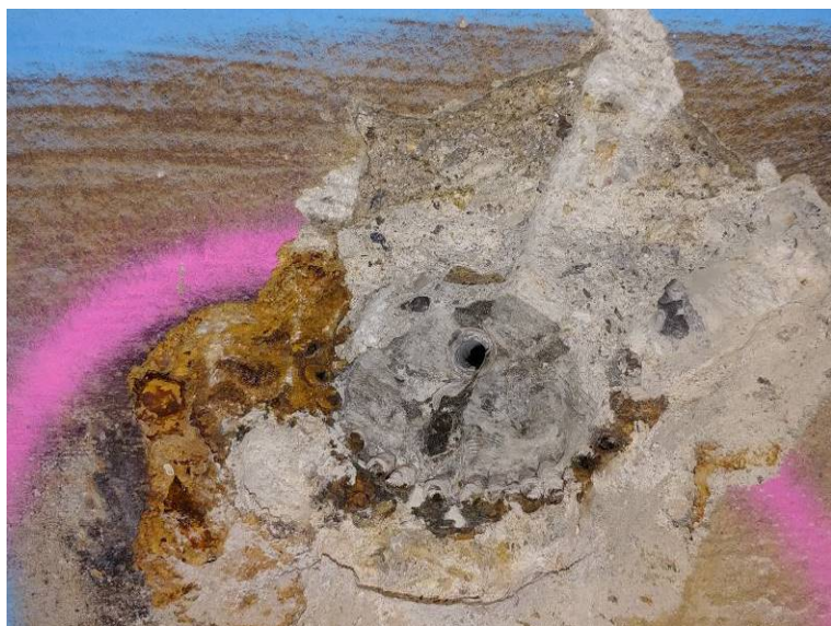
Sonda PVK 7 – po odstranění dobetonávky, koroze drátů ve spodní části
