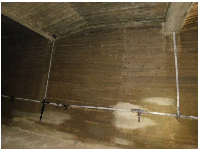
Stěny komory jsou nasycené vodou
