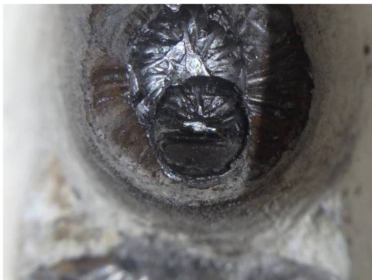
Sonda PV 16 – předpínací dráty bez koroze, ale vykazují tmavý povlak.
