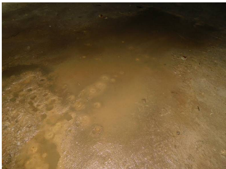
Zatékání do komory vstupním otvorem, v komoře se drží voda, bahno v poli 5
