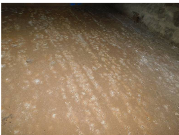
Porušený horní povrch dolní desky od odkapávající vody z horní desky v poli 5
