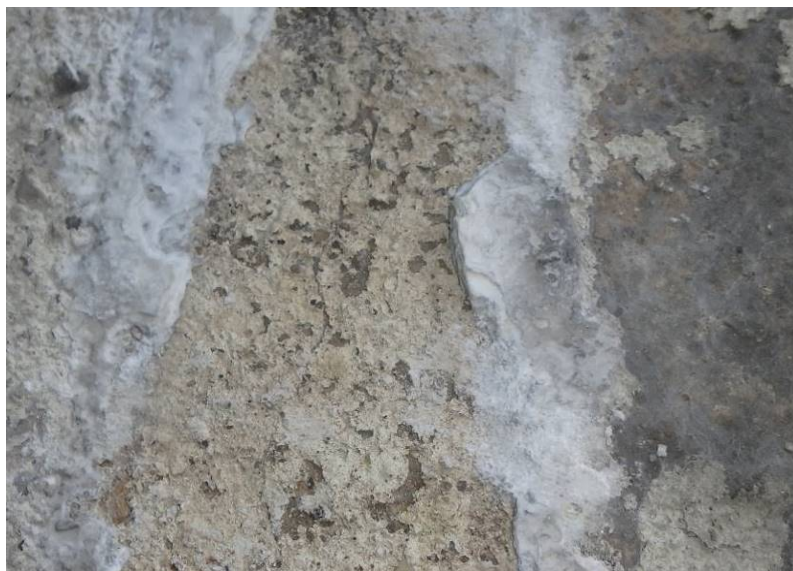
Detail vertikální trhliny pod vrstvou inkrustací
