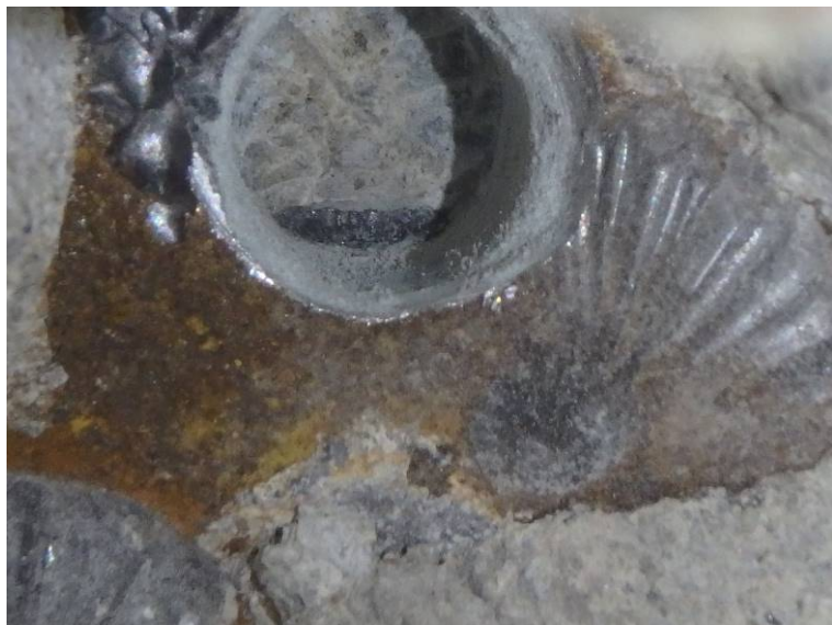
Sonda PV 8 – předpínací dráty bez koroze
