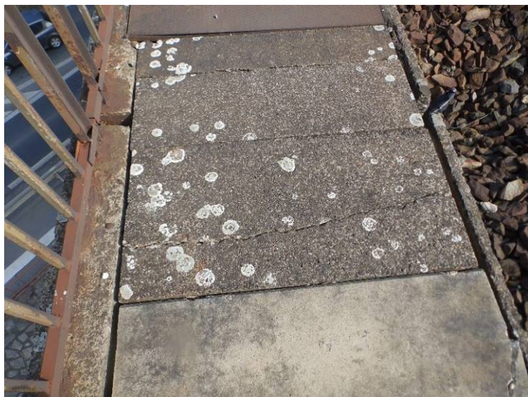
Prasklý betonový krycí panel kabelového žlabu.
