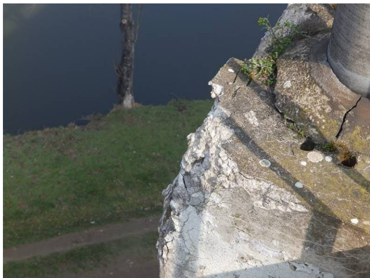
Degradace betonu na římse v místě stožáru trakčního vedení.
