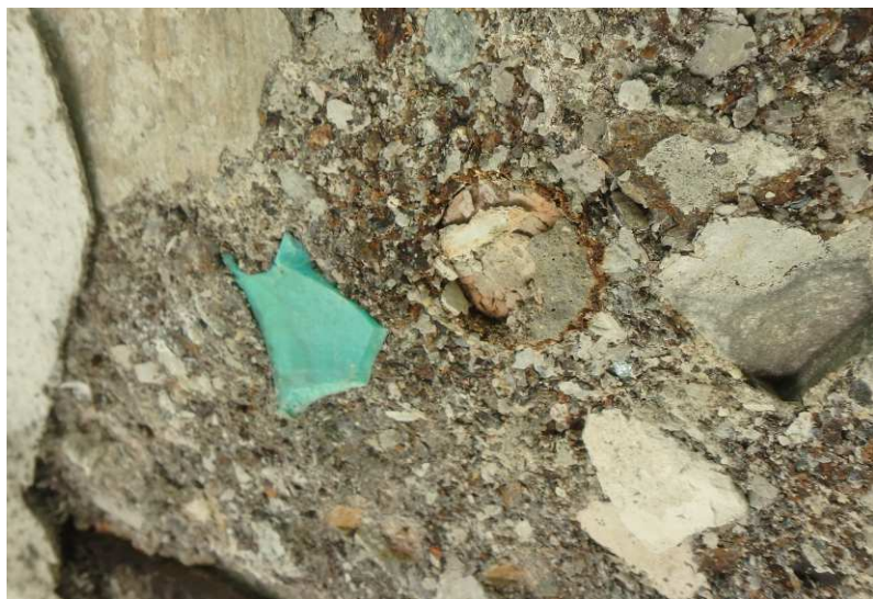
Detail struktury betonu pod omítkou – v betonu je vrstva nečistot z bednění (piliny, úlomky plastu, zátka od piva atd.)
