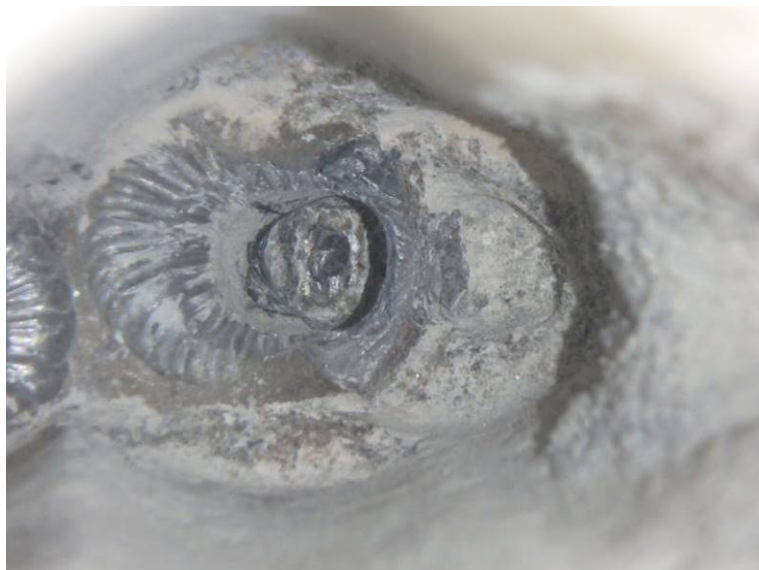
Sonda PV 25 – kanálek je zainjektovaný, předpínací dráty bez koroze
