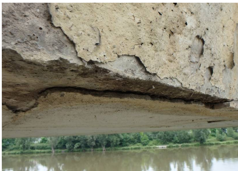
Detail dobetonávky – separace omítky.
