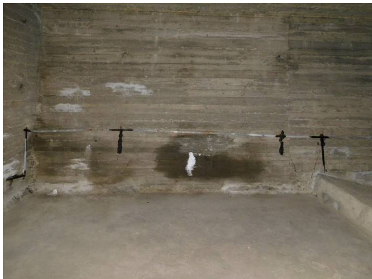
Lokální průsak na pravé stěně v poli 1
