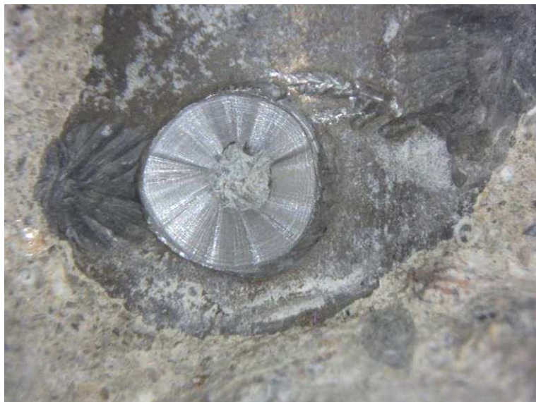
Sonda PV 22 – odvrtání chráničky – kanálek je zainjektovaný
