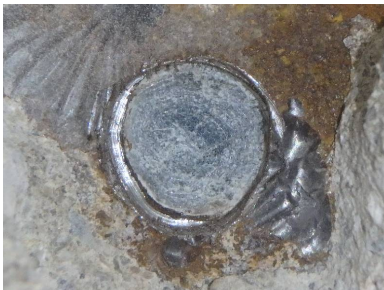
Sonda PV 8 – odvrtání chráničky – kanálek je zainjektovaný
