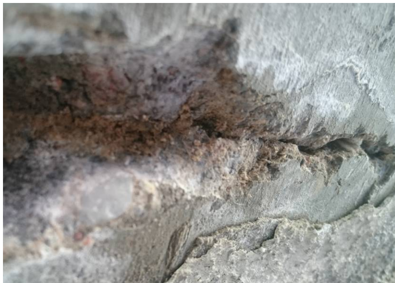
Detail poruchy – šíře trhliny je na povrchu až cca 3 mm. Směrem do hloubky se porucha zavírá, struktura betonu je mokrá a narušená. V hloubce 15 mm je již jen vlasová trhlina
