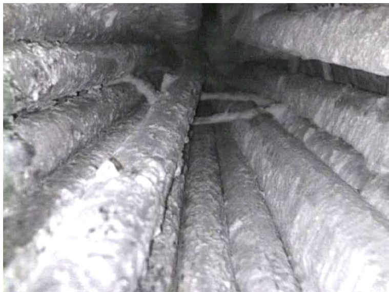
Sonda PVK 2 – pohled endoskopem pod kotvu – na snímku je patrná dutina pod kotvou a předpínací dráty
