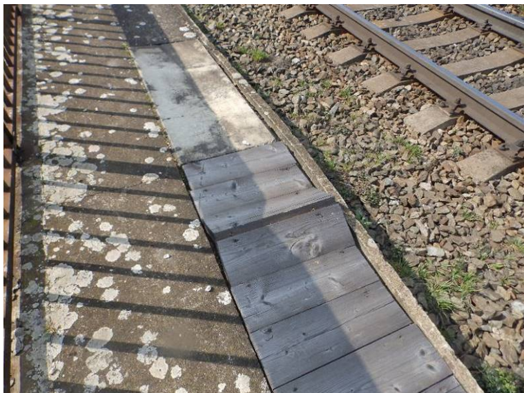
Deformované dřevěné fošny – zakrytí kabelového žlabu.
