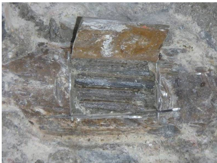
Sonda PV 4 – detail předpínacích drátů
