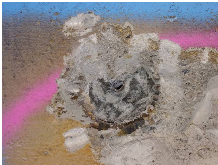
Sonda PVK 6 – po odstranění dobetonávky, koroze drátů ve spodní části
