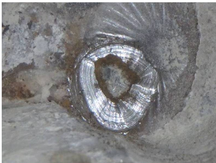
Sonda PV 13 – odvrtání chráničky – kanálek je zainjektovaný
