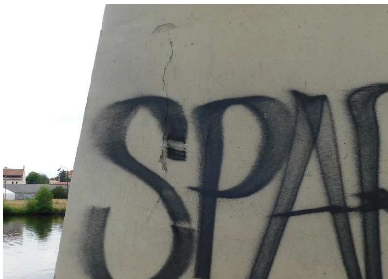
Pohled na svislou trhlinu se separací krycí vrstvy na rubové ploše rámové stojky pole 3 na P3
