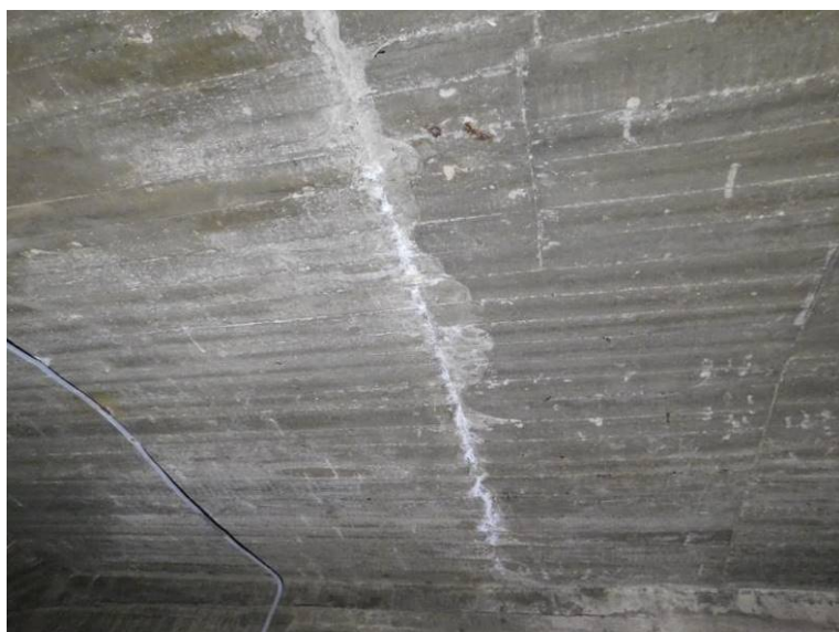
Výluhy v příčné spáře v poli 5
