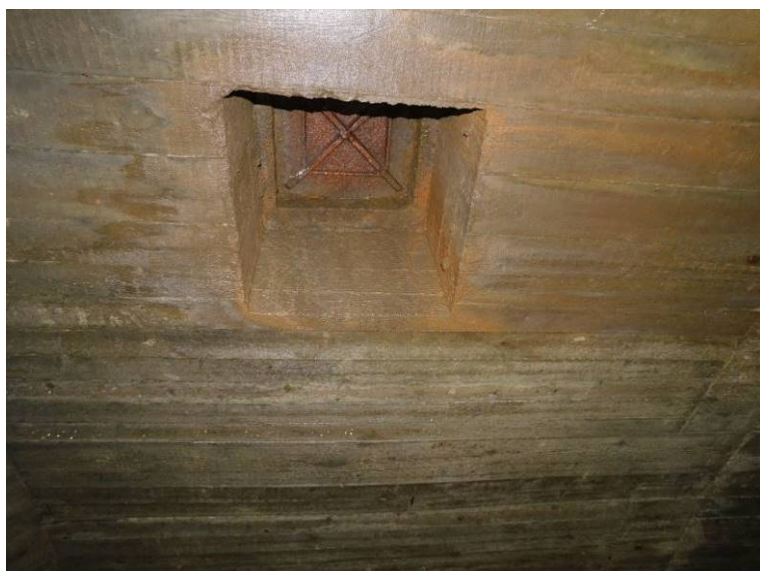
Beton v komoře je u vstupních otvorů mokrý
