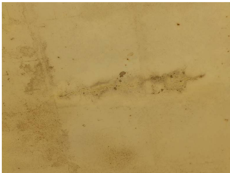
Podélná trhлина na spodním líci nosné konstrukce v poli 5
