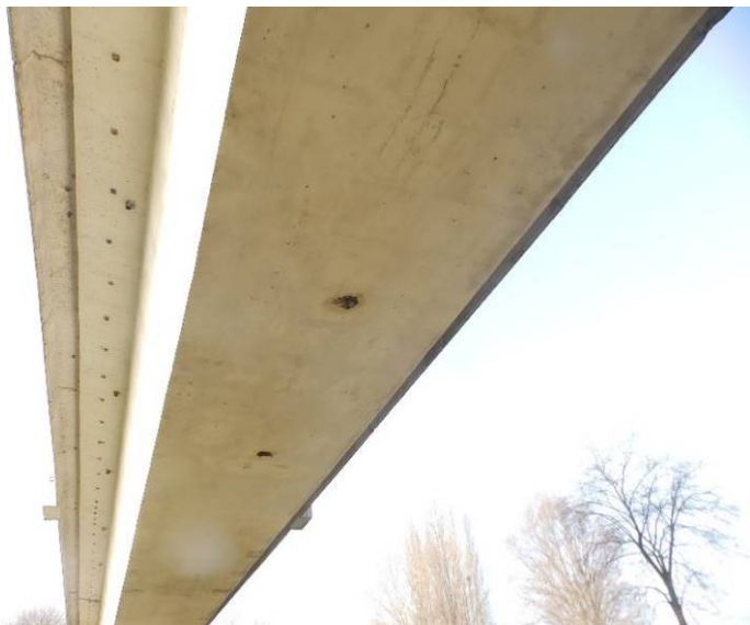
Zatékání na spodní líc nosné konstrukce z odvodňovacích otvorů v poli 4
