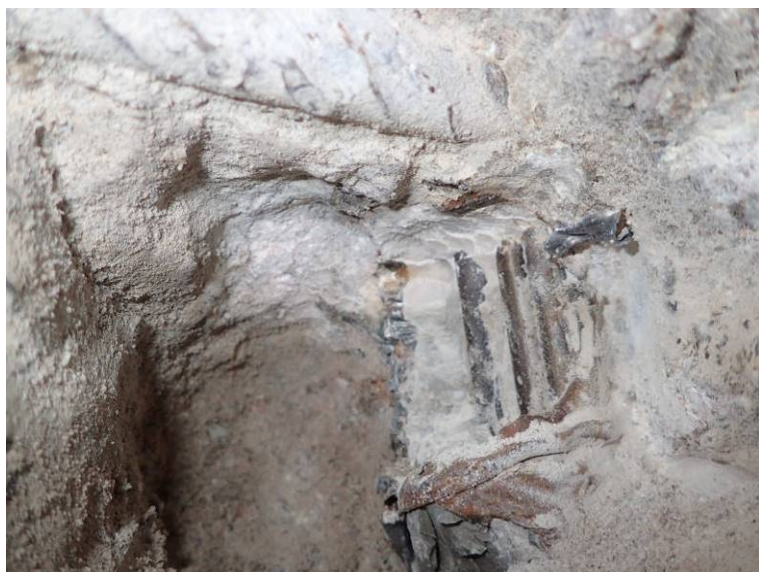
Sonda 19 – detail předeprnutého třmínku
