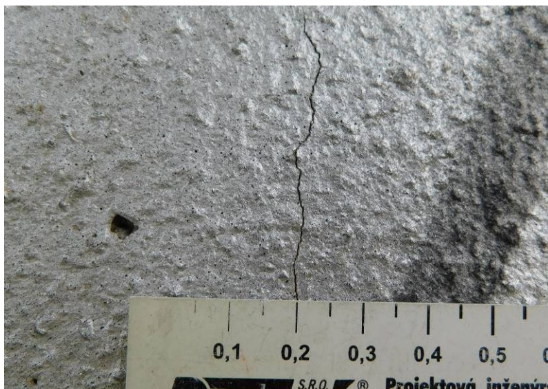
Detail typické vertikální trhliny na jedné z rámových stojek
