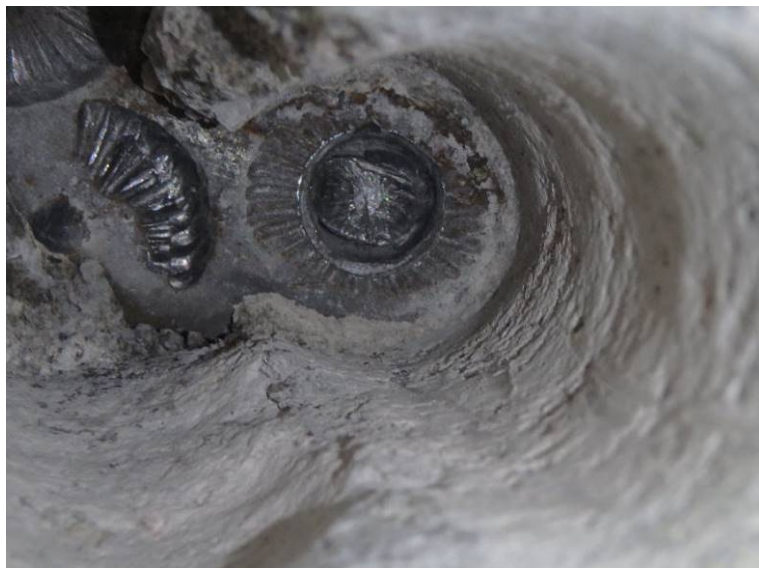
Sonda PV 26 – kanálek je zainjektovaný, předpínací dráty bez koroze
