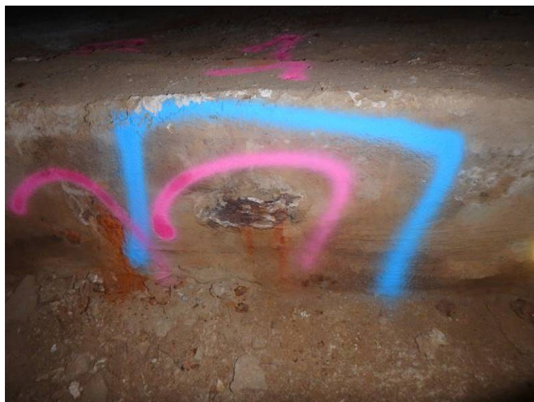
Sonda PVK 1 – pohled na kotvu se stopami koroze na povrchu dobetonávky – před zahájením prací
