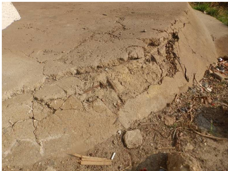
Hlubková degradace betonu na horním líci pilíře P4. Odhalená výztuž koroduje.
