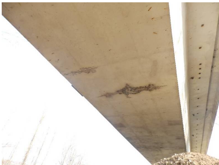
Příčné trhliny s výluhy na spodním líci nosné konstrukce v poli 5
