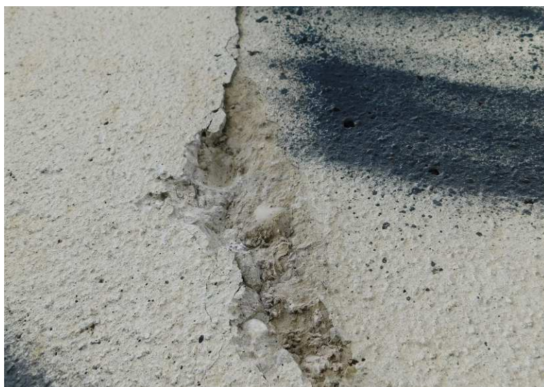
Detail okraje separované části – separovaná vrstva má šíři cca 0,3 m
